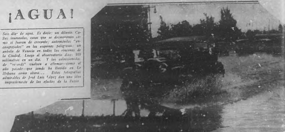
Un automóvil con veleidades náuticas! Esto ocurrió en la Quinta Avenida, a la entrada del Puente Habana
